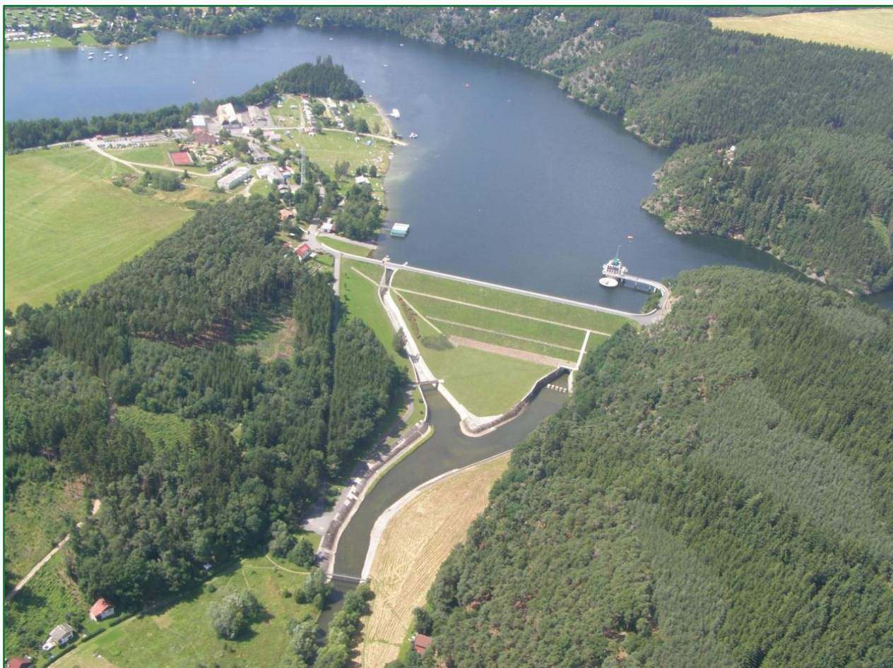
Vodárenská nádrž s jímacím objektem skupinového vodovodu
