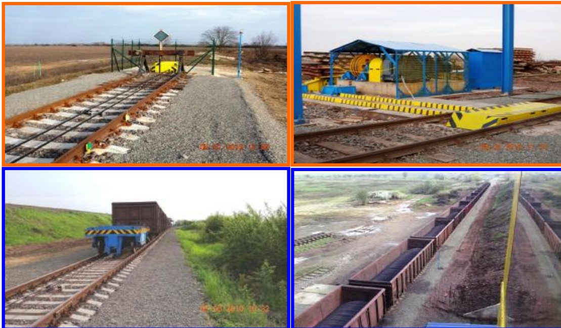
Obr. 7 Pohľad na tlačno-ťahné lanové zariadenie NV 200 NR pod III. vysokou rampou, hnacia a obratová stanica
