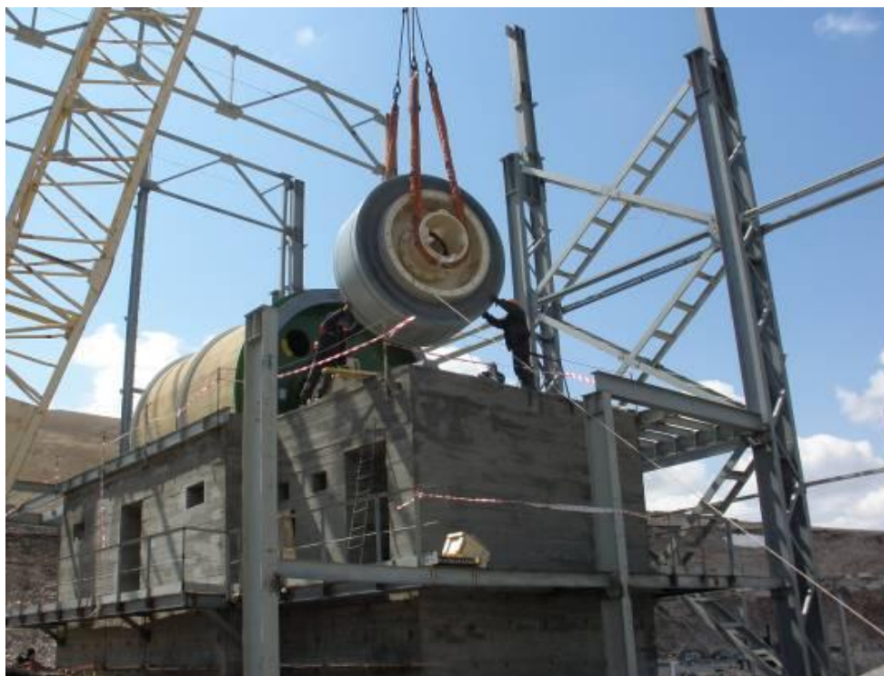
Obr. 3 Montáž rotoru na hřídel těžního stroje v Krasnokamensku
