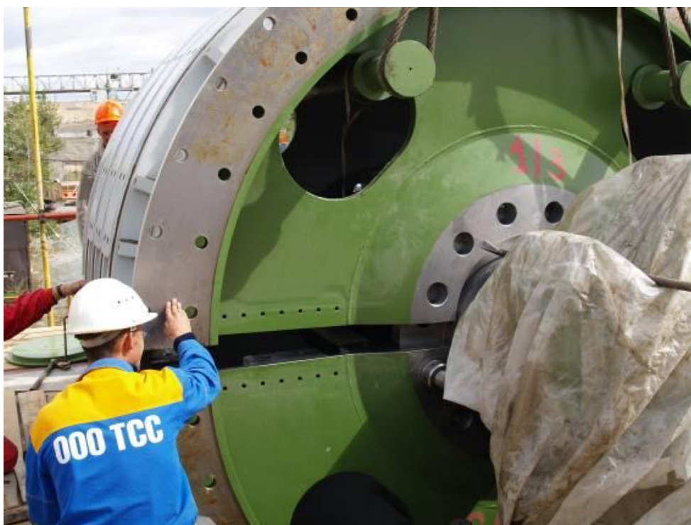
Obr. 2 Montáž těžního stroje 4K3316 - Gajský Gok
