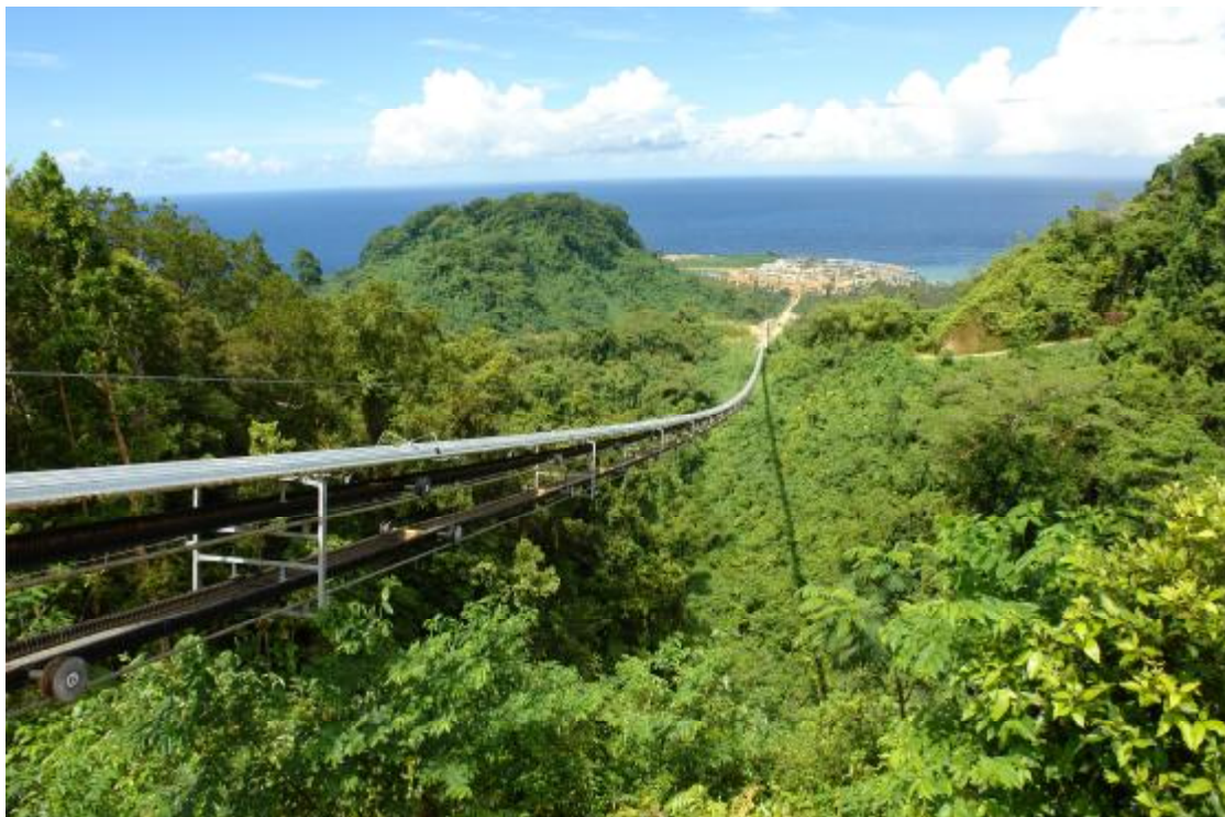
Fig. 1 RopeCon® Simberi (Blick von Stütze 2 Richtung Tal)
