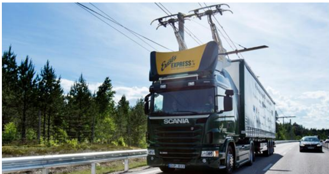
Trakčné vedenie pre nabíjanie nákladných vozidiel
