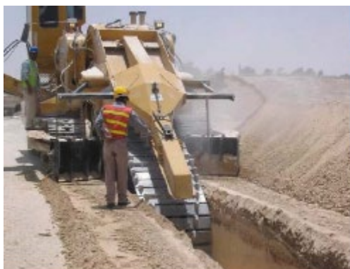
Obr. 5.182 Obdĺžnikový profil ryhy [9]
