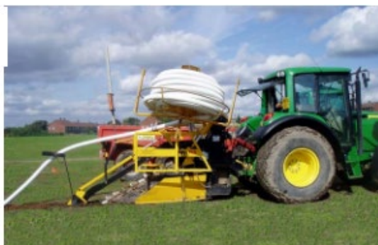
Obr. 5.200 Drenážny ryhovač AFT 100 pri práci [9]
