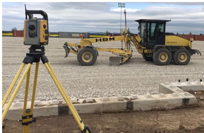
Obr. 5.56 Grejder vybavený 3D GPS nivelačným systémom [5]
