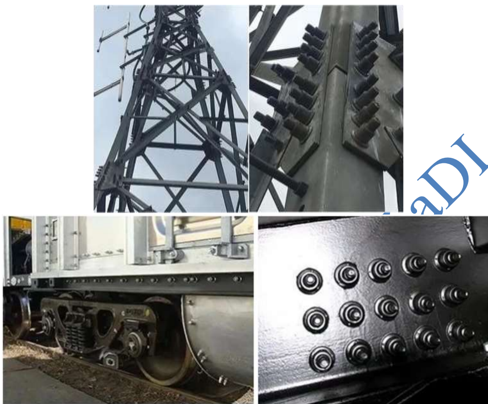
Obr. 3.33 Ukážky aplikácií uzamykacích skrutiek v konštrukciách [44]
