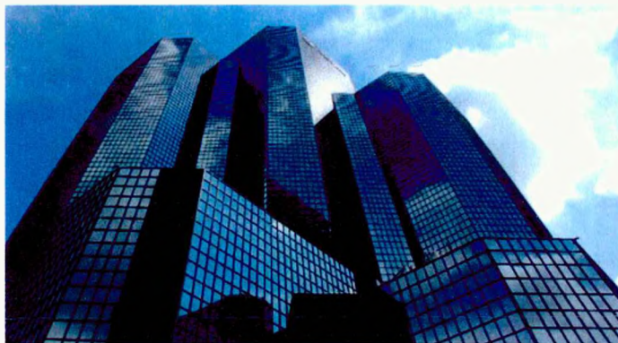
Obr. 3.4 Pohľad na stavbu so skleneným opláštením
