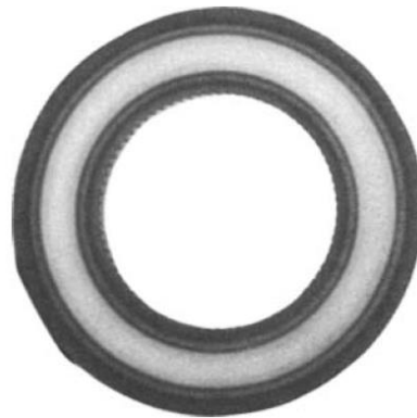
Obr. 3.17 Nauhličený vnútorný a vonkajší povrch ocelevej rúry
